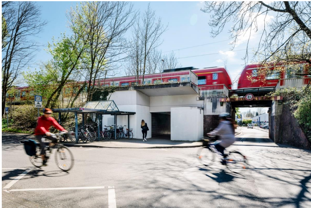
Abbildung 6: Überdachte Fahrradabstellanlage am S-Bahnhof Duckterath (© go.Rheinland GmbH/Smilla Dankert)
